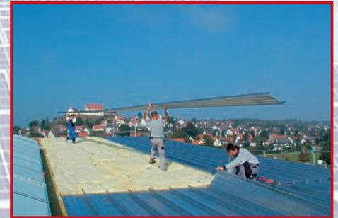
Das große Hallendach wird im Sept.06 isoliert und mit Kalziblech verschlossen
